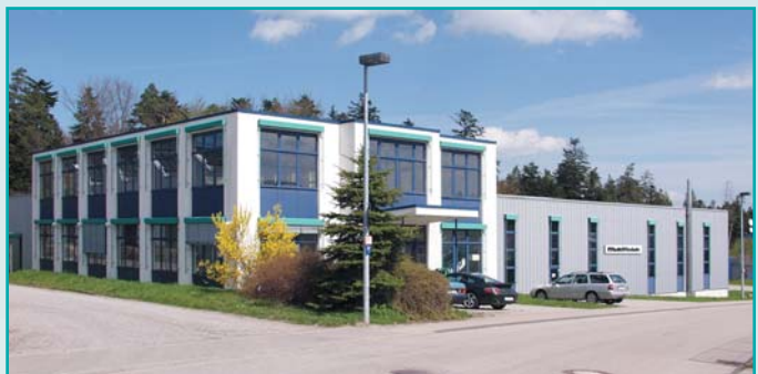
MultiFinish – Fabrikationshalle und Bürogebäude in Schömberg-Langenbrand bei Pforzheim (Deutschland)
